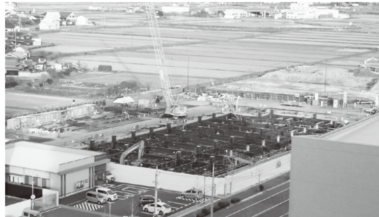
新庁舎建設(基礎工事)の様子(昨年12月10日撮影)
