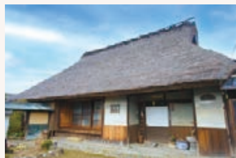
平成14年に市の有形文化財に指定された「奥田家住宅」(母屋)。江戸時代に建てられたとされる。
