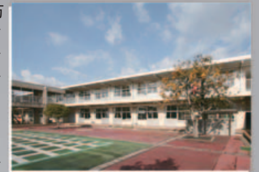
市場小学校の耐震改修事業
