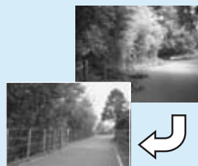
不法投棄防護柵の設置
