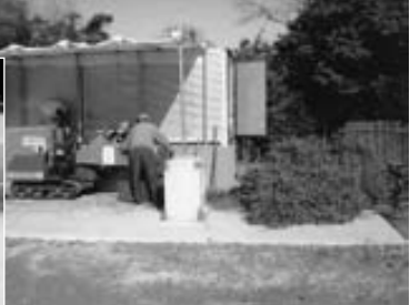
移動式破碎機でのチップ化作業
