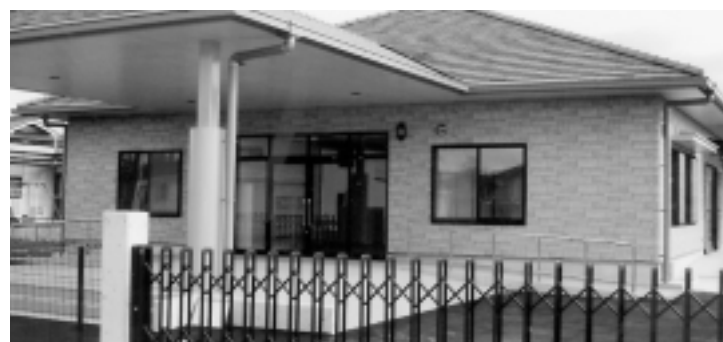
新しく完成した作業所「びっころもんど」
