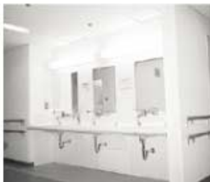
3階病棟洗面所
