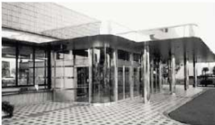
病院正面玄関の風除室
