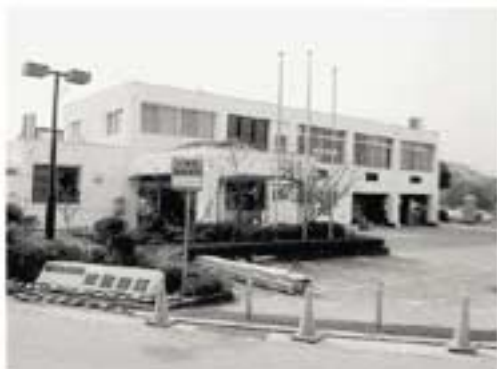
大規模改修工事中のコミセンいちば (昨年12月に撮影)
