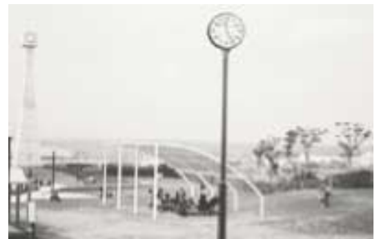
ひまわりの丘公園内に設置されたシェルターと時計塔
