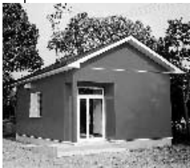
完成したクラブハウス
