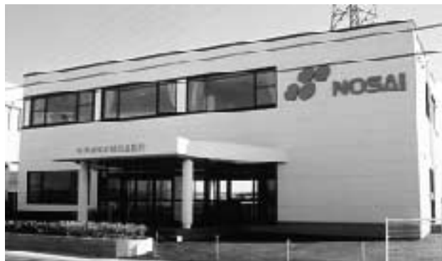
新しく完成した 同組合の新事務所 (鹿野町)
