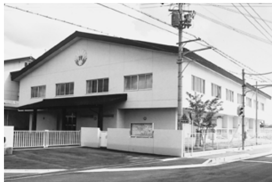
河合小学校体育館改築事業 (校舎改築に引き続き、体育館の改築を行いました)
