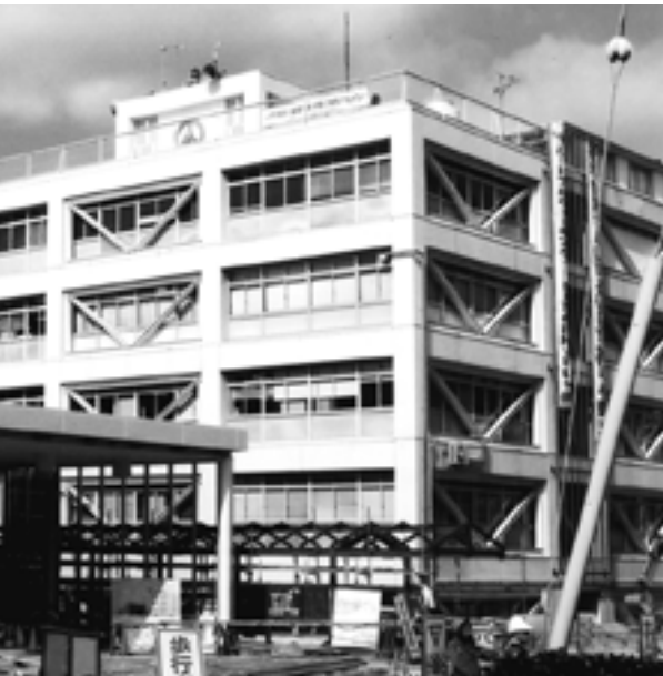
まもなく完成します
