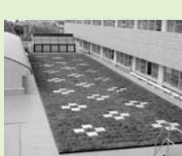
屋上防水緑化完成(2階病棟南側/MRI棟屋上より)
