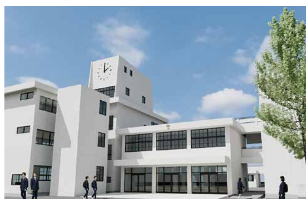
河合中学校の大規模改修
