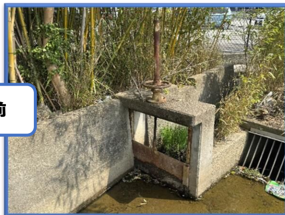
県営大部線8号分水ゲート改修工事
