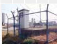
市場水源地第3水源井
