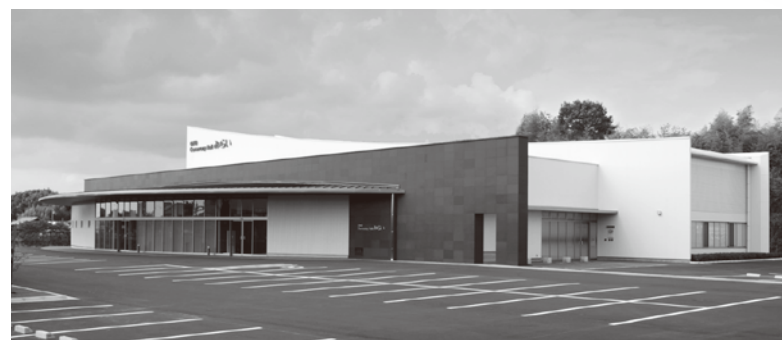
外観(南側から)
