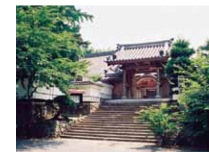
来迎寺(現在は工事中)
