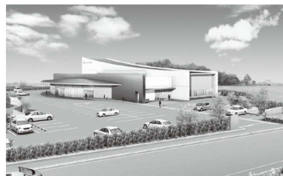
建物概要 [場所]敷地町 [構造]鉄骨造・平屋建 [延床面積]1,619平方メートル
