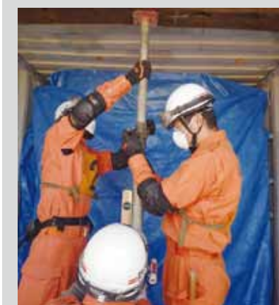
地震災害などによって倒壊の危険性がある建物の安定を図り、救助隊員の安全確保と、円滑な救助活動を実施するショアリング
