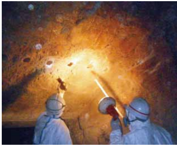
毎週行う焼却炉内の点検
