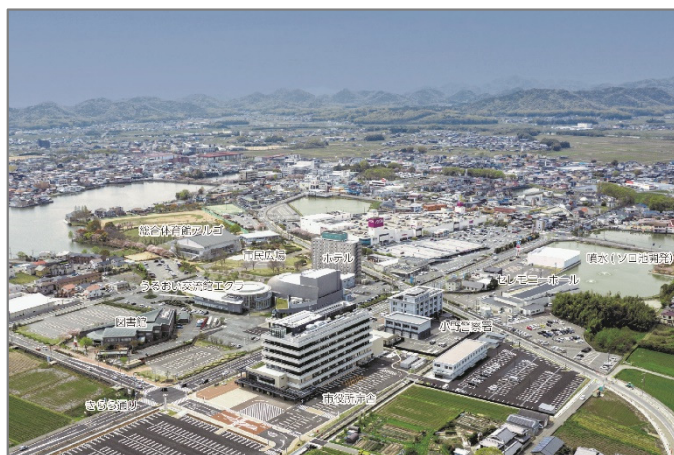
事業区域（シビックゾーン）全景写真
