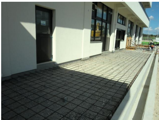
南棟 1 階テラス土間配筋
