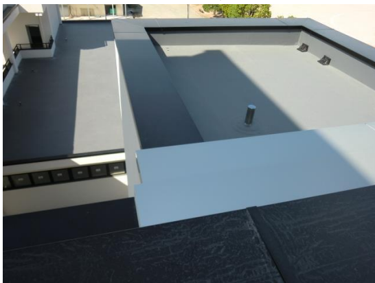
EV 棟屋根シート防水、EXP.J カバー
