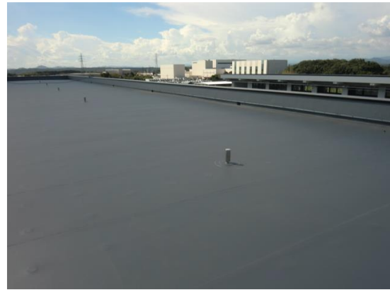
南棟屋上シート防水、脱気筒
