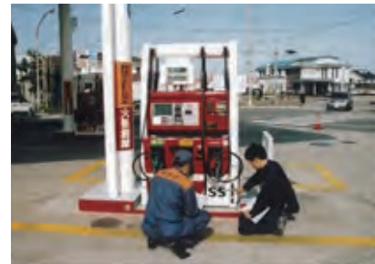
■危険物施設完成検査
