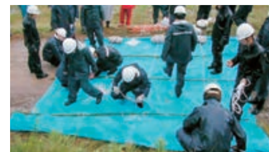
■防水シート張り工法(水辺ふれあい公園)
