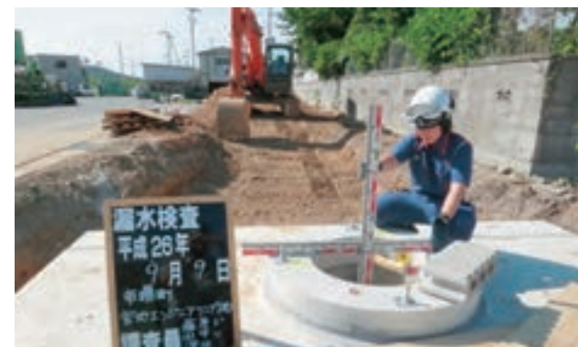
■新設防火水槽漏水検査
