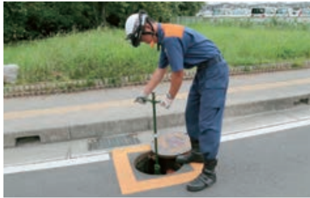
■消火栓の点検
