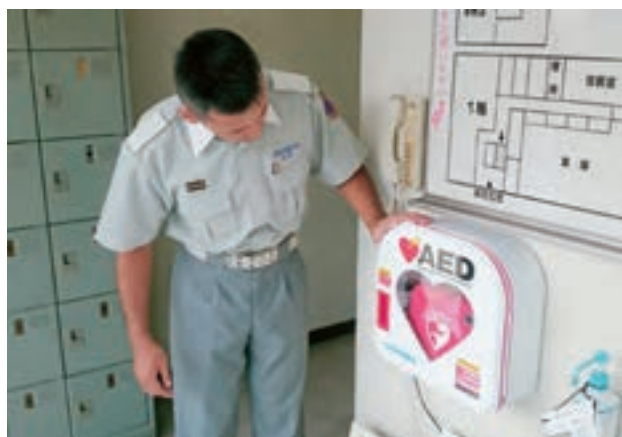
■市内の各公共施設に設置してあるAED (消防署南分署)
