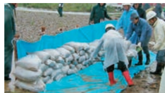
■改良積土の工法(水辺ふれあい公園)
