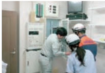
■設置された消防用設備の検査
