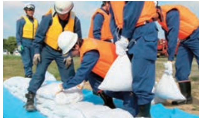
■改良積土のう工法Ⅱ
