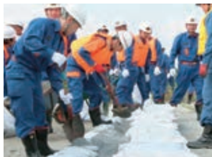
■積土のう工法
