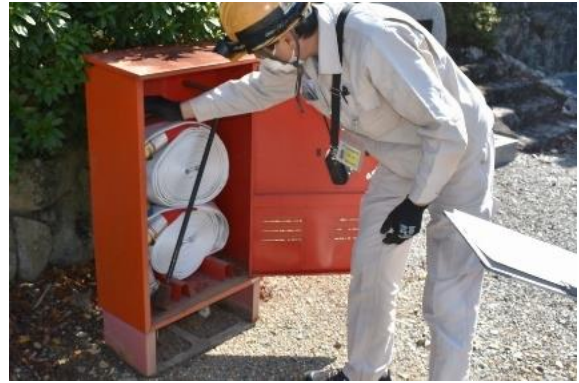
消防ホースの点検
