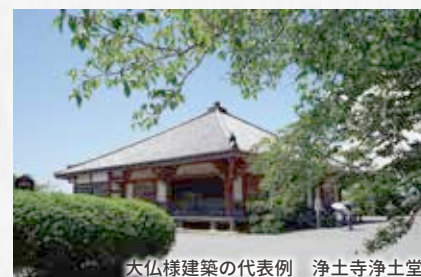
大仏様建築の代表例 浄土寺浄土堂
