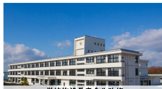
学校施設長寿命化改修
