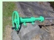
ゲート、バルブの更新
