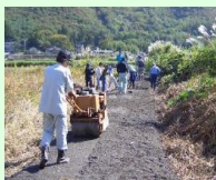
未舗装農道の舗装
