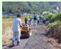
未舗装農道の舗装
