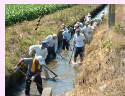
水路の泥上げ
