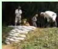
漏水箇所の補修
