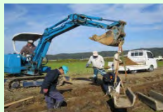
コンクリート水路の更新
