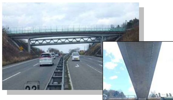
天神第3跨道橋（30歳）判定区分Ⅱ
