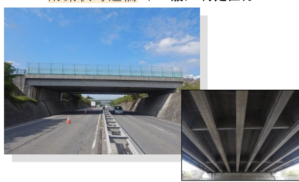
南環状跨道橋（33歳）判定区分Ⅱ
