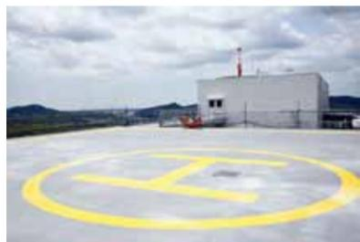
救急の受け入れ態勢の充実、強化を目的に、屋上にヘリポートを設置。病气やケガをした救急患者の受け入れや大規模災害の発生によって交通網が遮断された場合でも、迅速な受け入れができます。なお、現在の兵庫県消防防災航空隊が運行するヘリコプター (全長 13 尺) の離着陸はもちろん、大型ヘリコプター (全長 17 尺) の離着陸にも対応しています。
