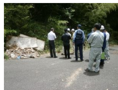
市場町: 山田の里公園北国道の側道
