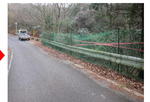
再発防止のための不法投棄防止ネットの設置
