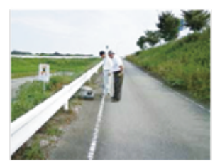
古川町：R175号小野大橋北側市道脇
